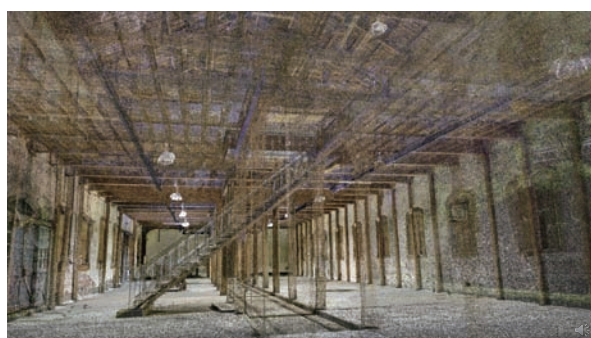
Fig. 2 需品庫内部点群表現（内部1階と2階） 2階の床面を透かして屋根のトラスが見える
