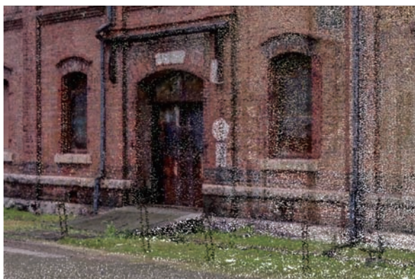
Fig. 8 BIM 上に点群を展開 (外観) Fig. 9 と比較して、視点場により内部の見え方が異なる。
