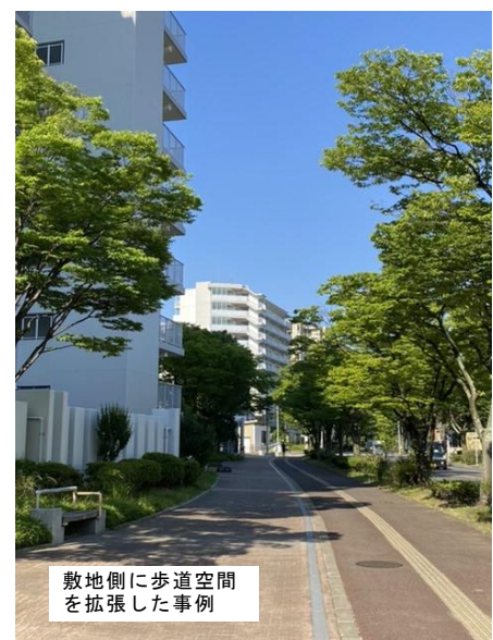
写真 3-5 歩道拡張空間 (2-4 街区) 注 3-1)
