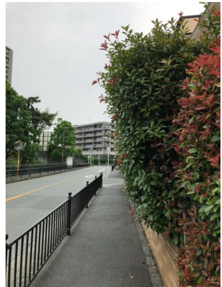
写真 2-8 歩道へ越境する植栽 ※生垣樹種はベニカナメモチ (1-2 街区) 注 2-1)
