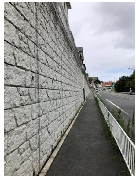
写真 2-7 高擁壁と歩道空間 ※擁壁高さは約4mである (1-9街区) 注2-1)
